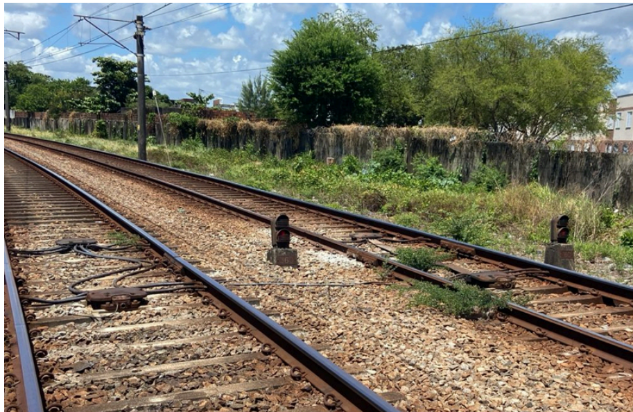
Foto 01: Exemplo de trechos em curva com trilhos a serem substituídos na Linha Centro
